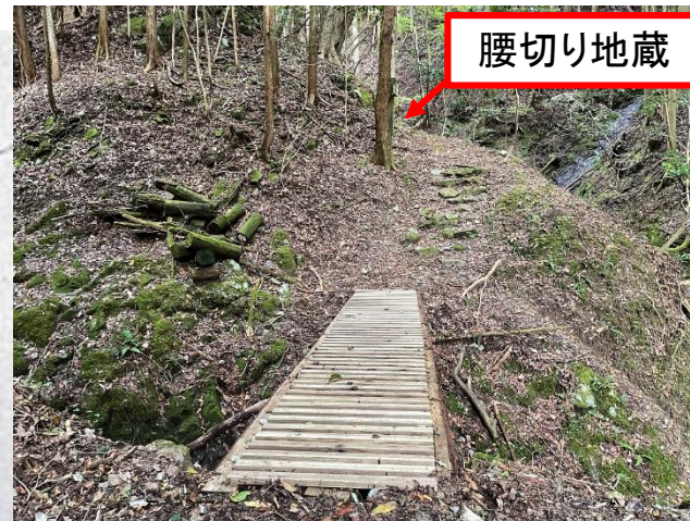
①渡り橋 修繕完了！
